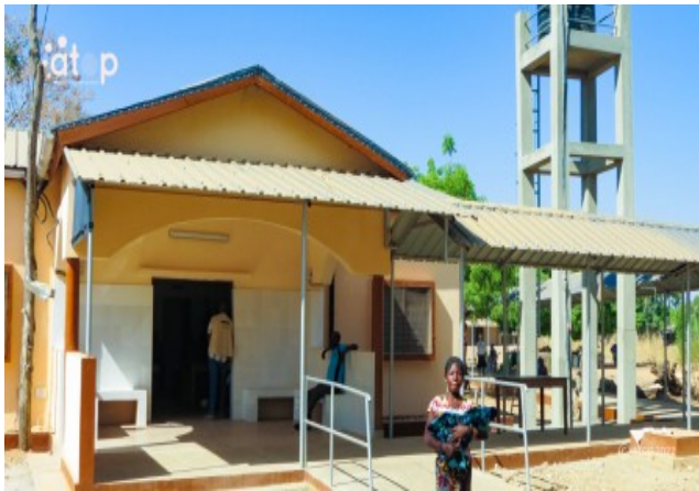
L'entrée de l'USP Nadoba réhabilitée
